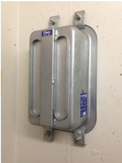
Überdruck-Ventil (UeV)
